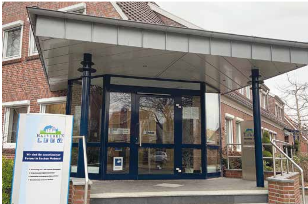
Die Bauverein-Verwaltung in der Edzardstraße.
